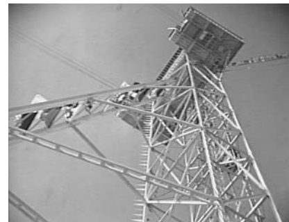
UNE ŒUVRE, UN PEUPLE (1940), LE PILIER DU TÉLÉPHÉRIQUE RELIANT LES DEUX RIVES DU LAC
